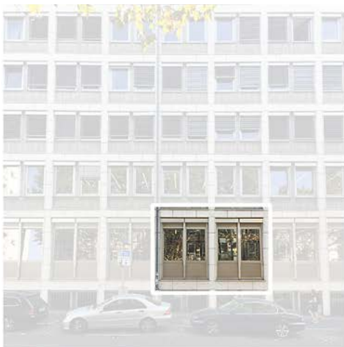
Bestandsfassade Hasengasse | Ausschnitt
