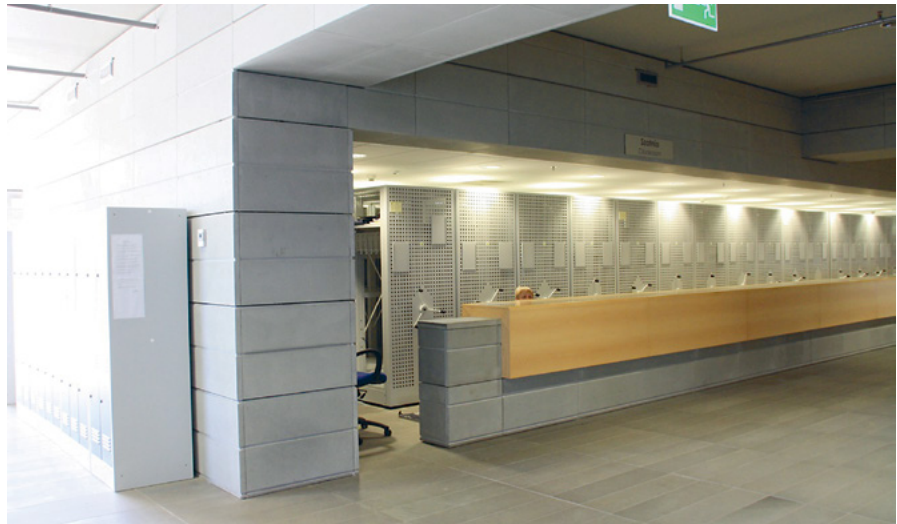
Hebeschubanlage als Garderobe.
